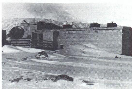
Fig. 1B Baksiden av Norlysstasjonen som vender mot øst, er uten vinduer og skjermet for lys fra Longyearbyen og trafikken gjennom Adventdalen. På observasjonsplattformen står spektrometer, norlyskamera og svepende fotometre i spesialbygde bokser.
