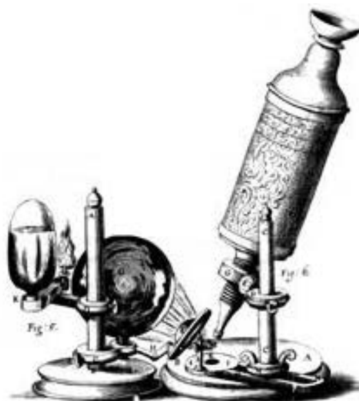
Figur 1. Skisse av mikroskop fra 1600-tallet. Belysningsanordning ses til venstre, og sylinder med okular og objektivlinse til høyre.
