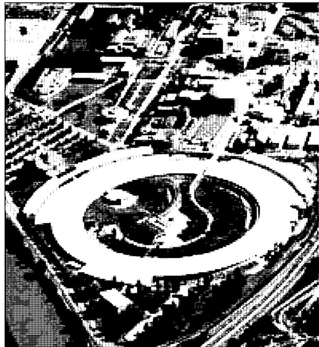
**Figur 1.** ESRF-anlegget. Den sentrale ringen huser lagringsringen og de opprinnelige strålelinjelaboratoriene. Omkretsen av lagringsringen er ca. 1 km. Ny bygningsmasse kan sees på utsiden av ringen. I øvre høyre region vises også reaktoren til *Institute Laue-Langevin* der det produseres nøytroner for forskningsøyemed.
